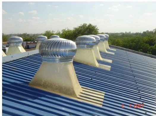
Fig.No. 3 Natural Air Ventilators
